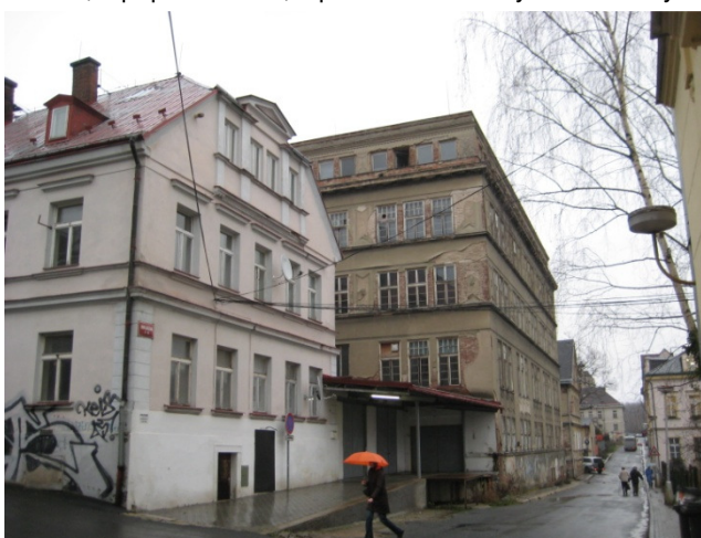
Pohled do ulice Oblačná z Křižovatky s ul. 8. března. Vlevo vila E, za ní část budovy bývalé tiskárny.
