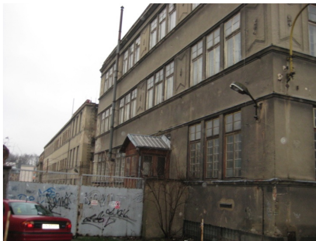
Pohled na dva bloky budov bývalé tiskárny v ul. U Tiskárny z křižovatky s ul. Boženy Němcové.
