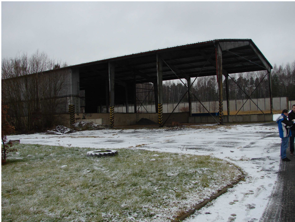
kolna na stroje, střecha bude zbourána
