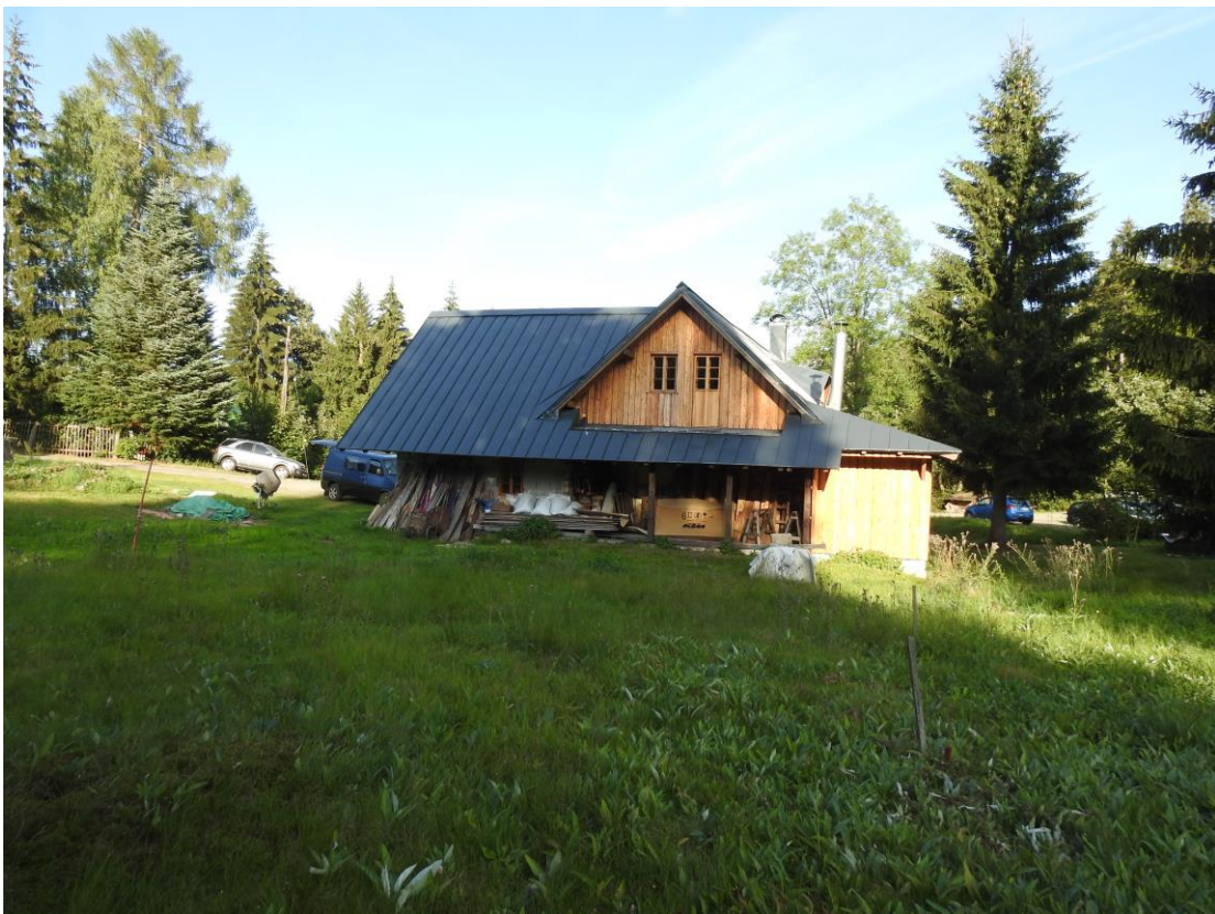
Obr. 3: Jako zázemí bude návštěvníkům sloužit stávající objekt č.p. 667
