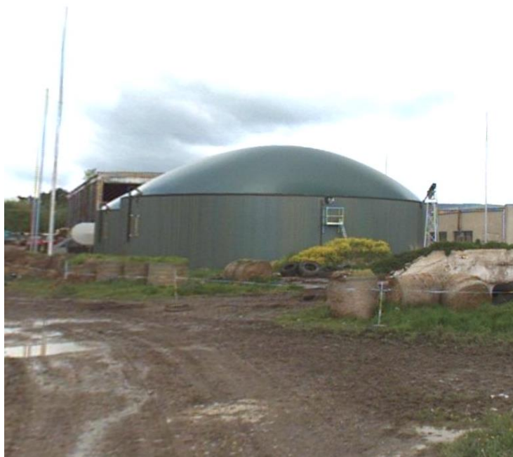
Pohled na stávající bioplynovou stanici
