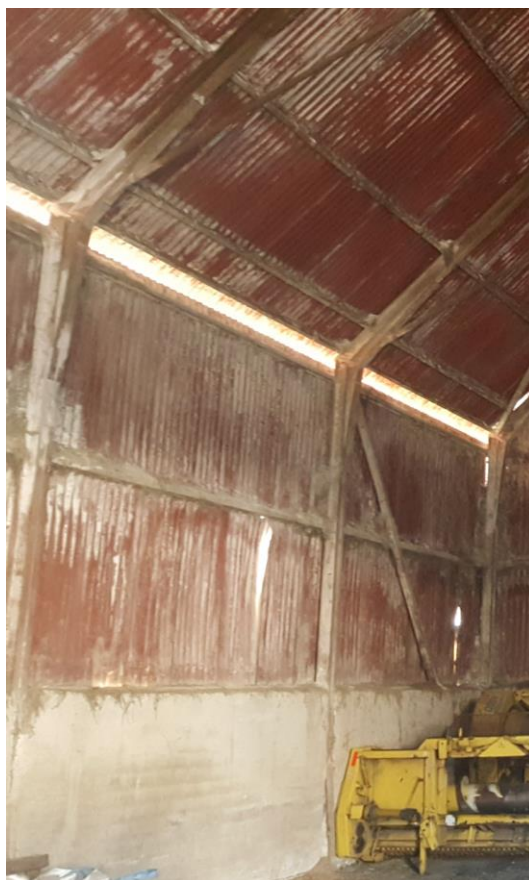
Interiér stávající haly určené k rekonstrukci a vestavbě linky
