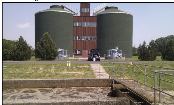
Vyhnivací a uskladňovací nádrže
