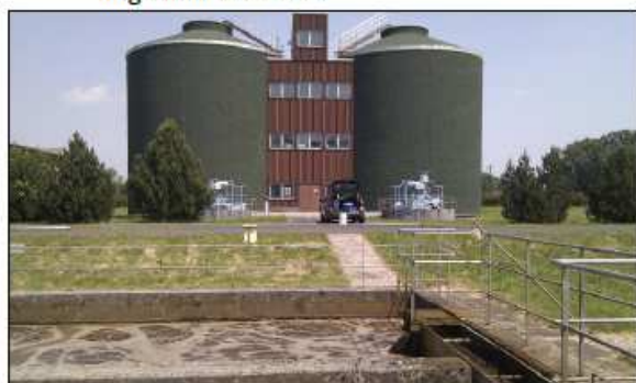
Vyhňivací a uskladňovací nádrže
