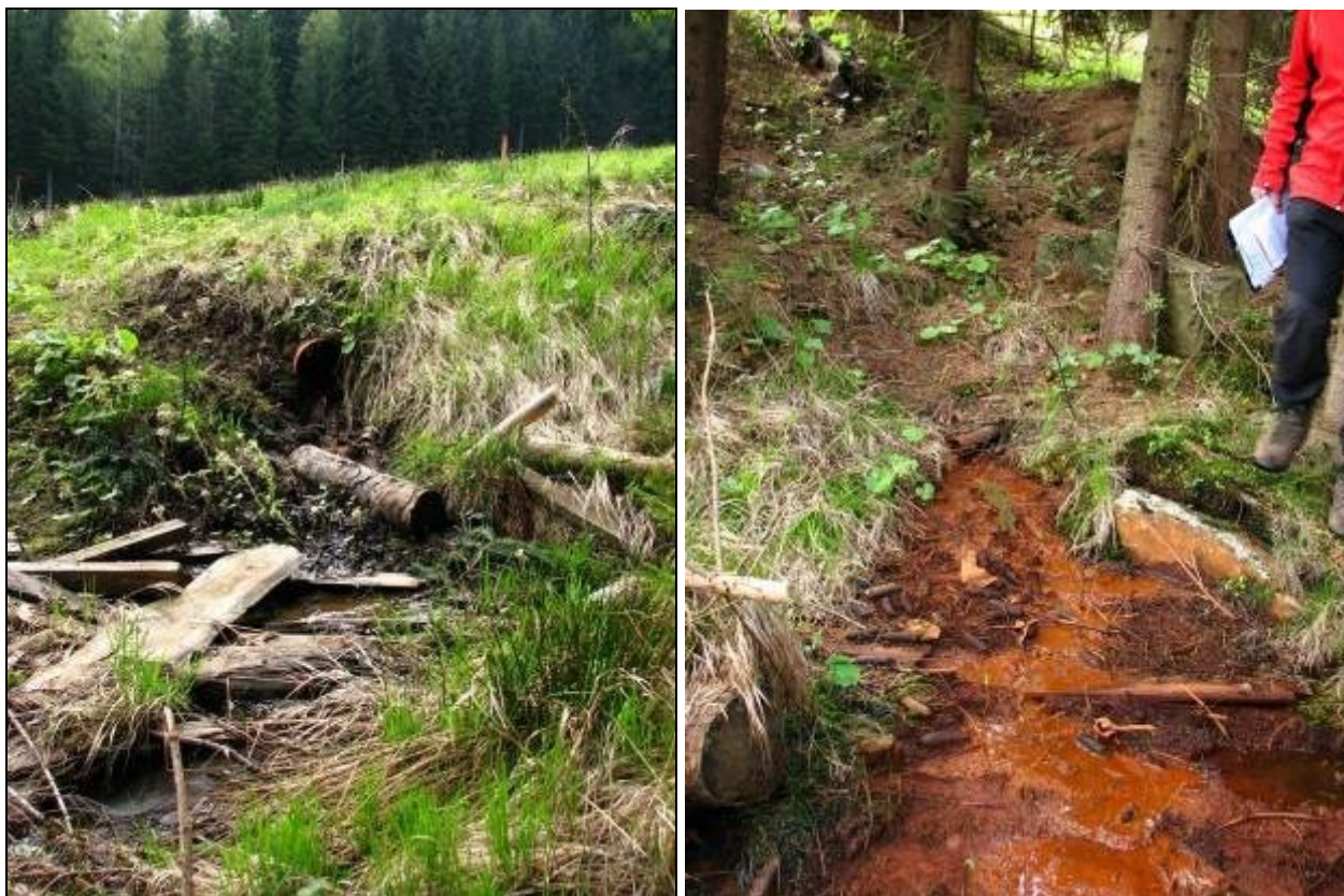
Foto 3-4. Do lesních porostů dotčených záměrem cvičného svahu je aktuálně svedeno odvodnění stávající červené sjezdovky, které místy výrazně přispívá k podmáčení terénu. Oba snímky pochází z rozhraní západního okraje dnešní sjezdovky a projektovaného cvičného svahu.
