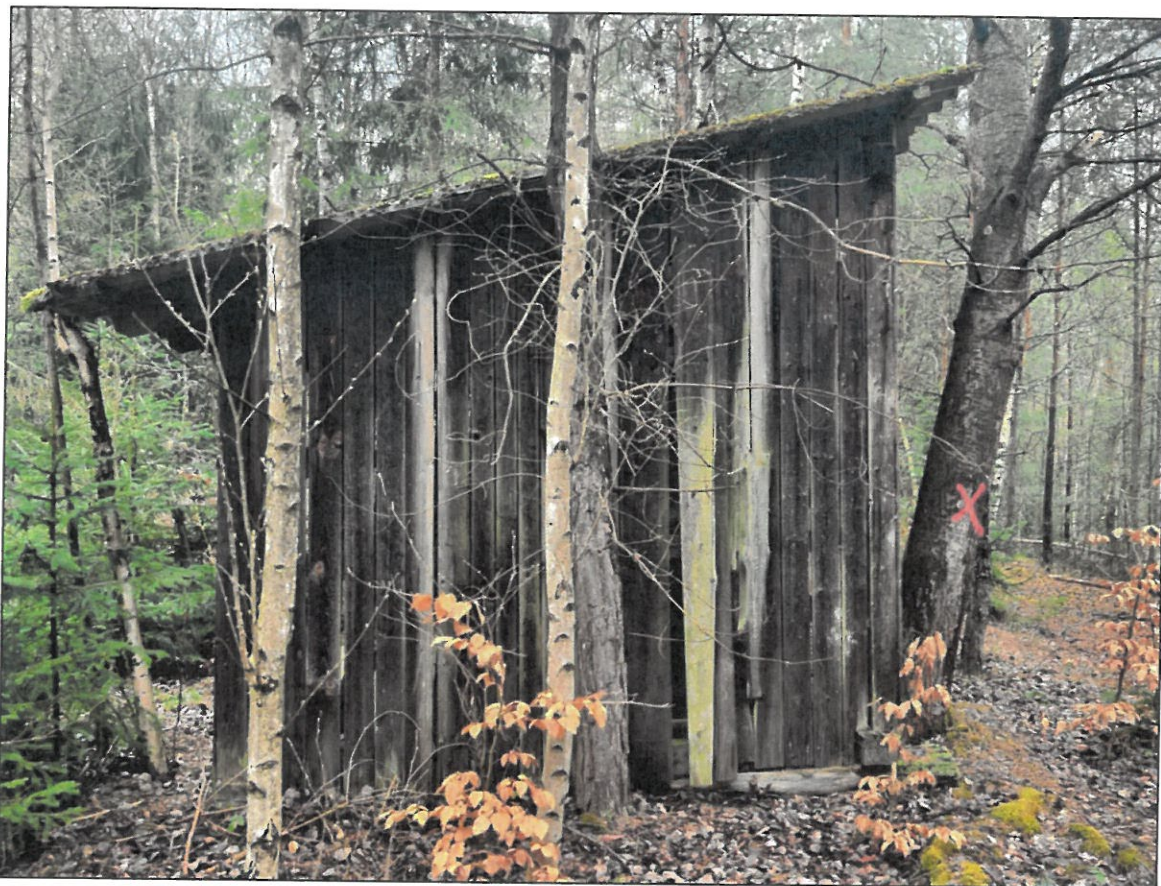
Obr. 8 – pozůstatek dřevěné stavby na severovýchodním okraji lokality a ukázka značení stromu, který má být ponechán.
