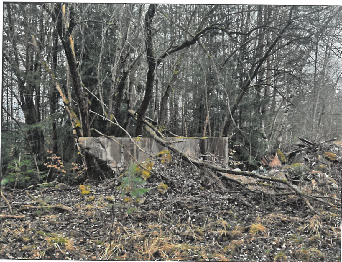
Obr. 11 – pozůstatky staveb spojených s těžební činností na lokalitě, vč. stavebního odpadu.
