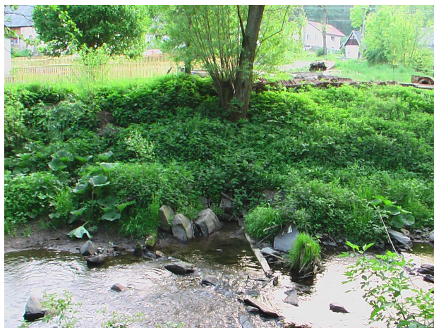
Pozůstatky po původním jezu
