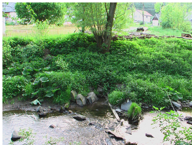
Pozůstatky původního jezu
