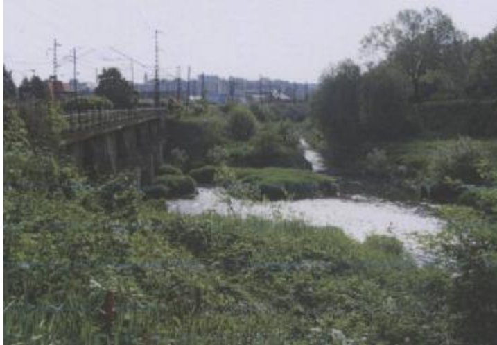
prostor výstavby SO 20-04
