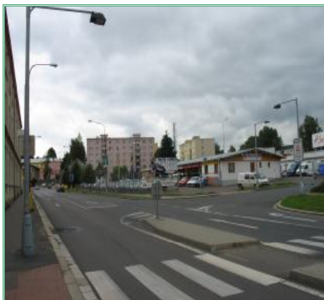
Obr. 12 Silnice I/14 - směr centrum
