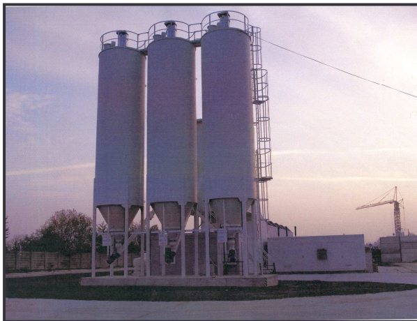
Obr. č. 3: Cementová ocelová sila
