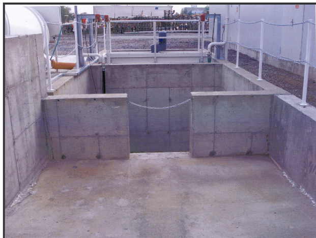
Obr. č. 4: Kalová jímka recyklace
