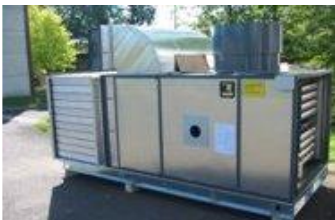
Obrázek 5 : Přívodní vzduchotechnická jednotka
