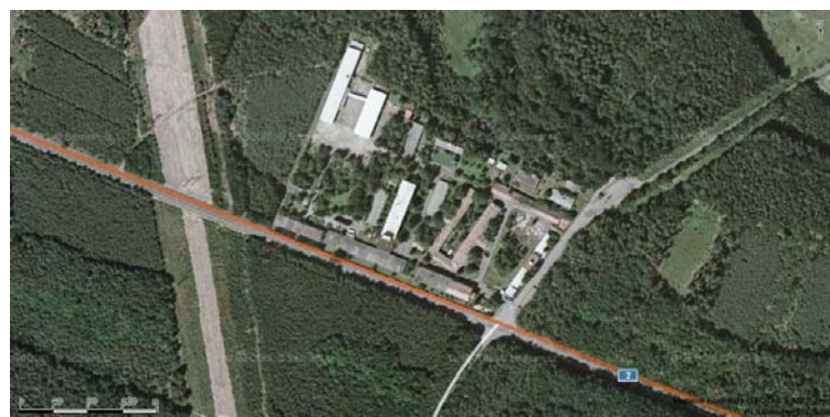
Obr. č. 2: Letecký snímek areálu
