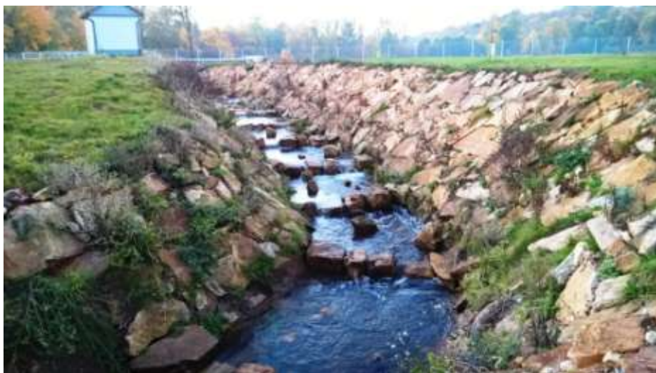
Obrázek 2: Typický balvanitý rybí přechod na Labi u Heřmanic
