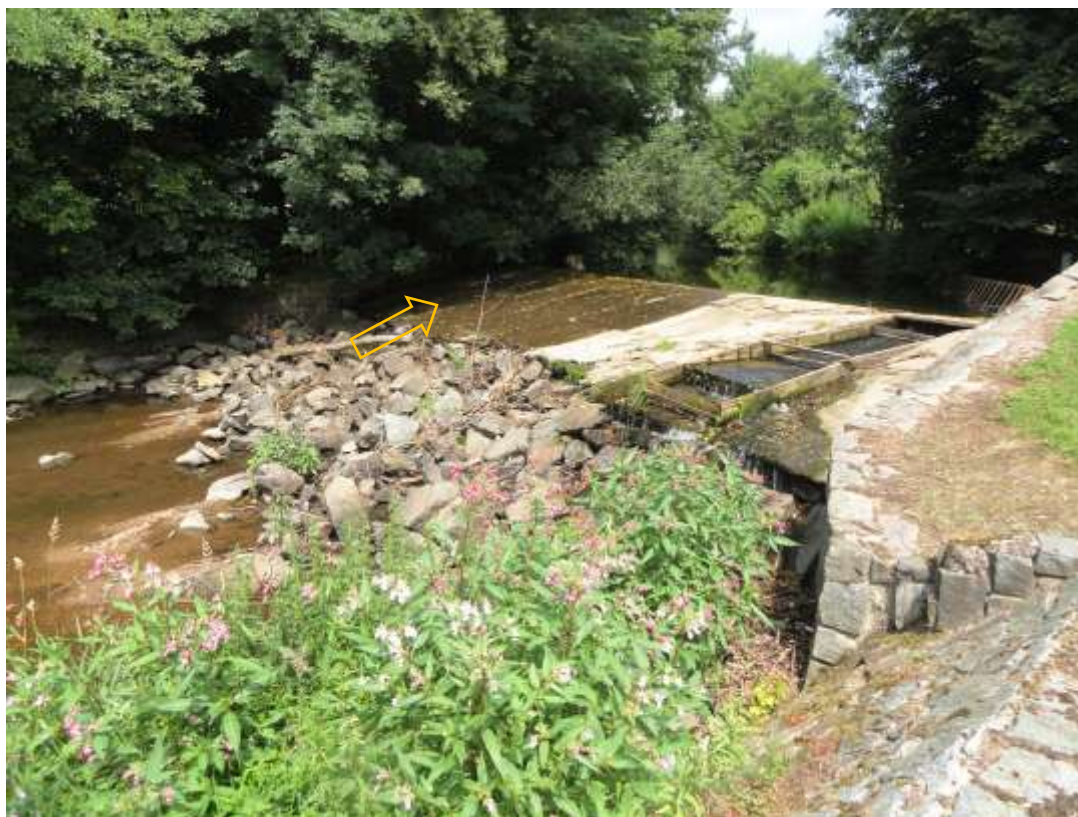
Obr. 3 Celkový pohled na těleso starého jezu
