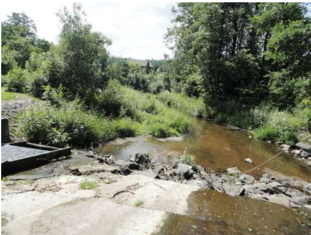
Obr. 5: Pohled na současný stav koryta řeky v podjezí
