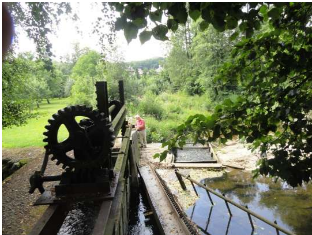
Obr. 6: Česle a stavidlo pro odběr na MVE, vlevo zahrada „na ostrově“ při vzorkování nárostů
