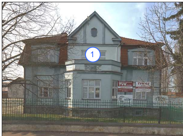
Měřicí bod 1, Pražská 147 (1 byt ve 2.NP)
