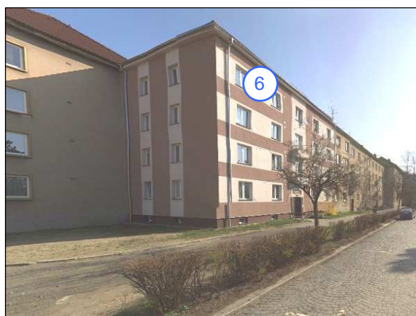
Měřicí bod 6, Hlaváčova 2541, bytový dům
