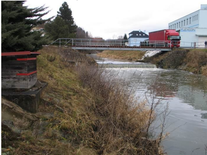
Foto 1: Pohled na objekt SO 01.
