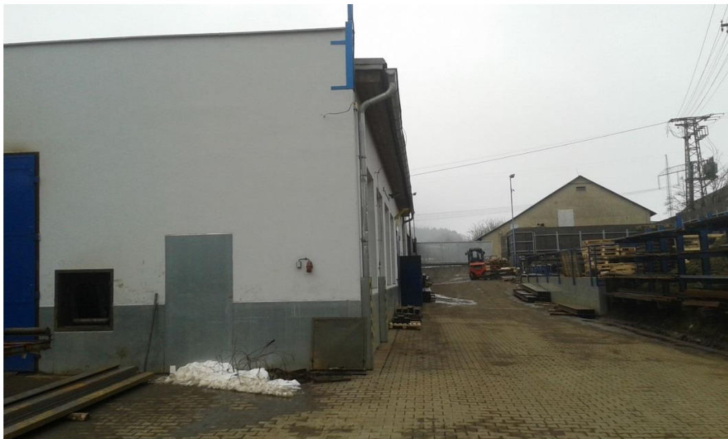
Obrázek 3: Manipulační plocha na severní straně budovy
