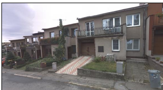
RB5 - bytovky č.p. 413 - 417
