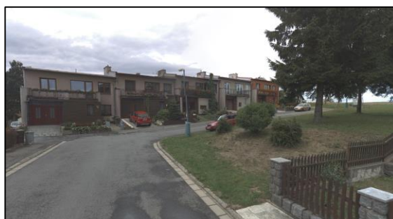
RB6 - bytovky č.p. 408 - 412
