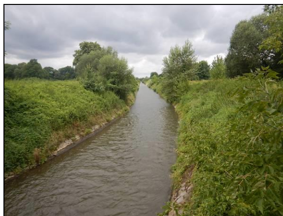
Odpadní kanál pod elektrárnou EOP je zcela odpřírodněným vodním tokem
