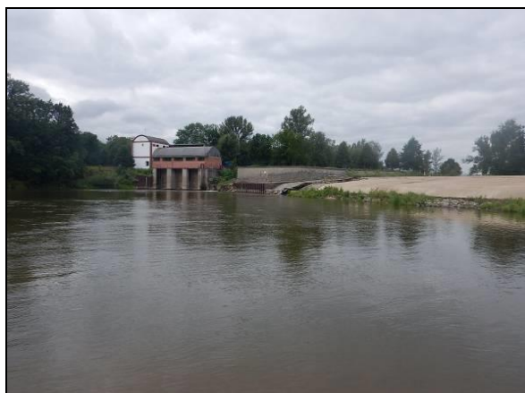
Jez v Opatovicích nad Labem – místo odbočení Opatovického náhonu a přívodu vody pro EOP
