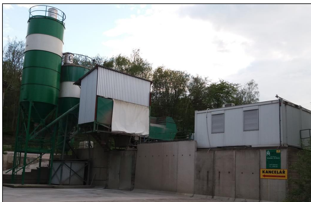
Obrázek č. 6: Konstrukční řešení mobilní betonárky AMB 22 (foto: květen, 2019)
