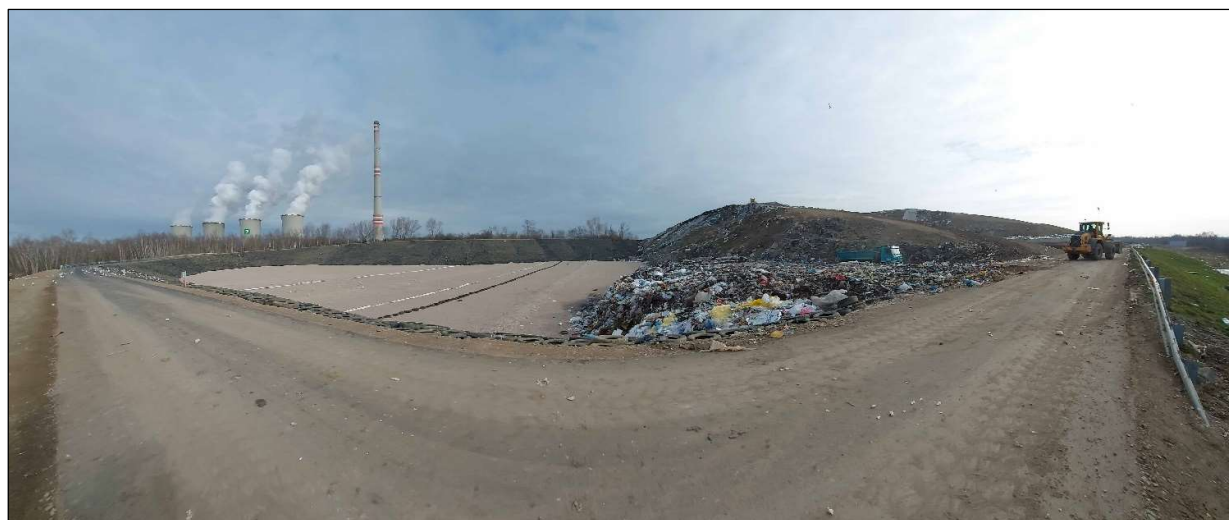
Foto 2: Příprava prostoru pro ukládání VI. etapy, vpravo ukládání v V. etapě. (Geo Vision s.r.o., březen 2021)
