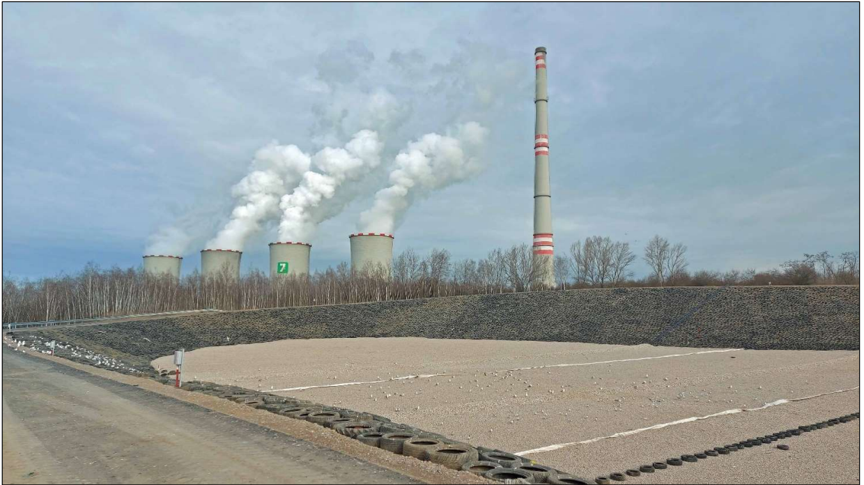
Foto 3: Prostor pro VI. etapu v bližším pohledu, kde je vidět zatěsňování skládkového prostoru. (Geo Vision s.r.o., březen 2021)
