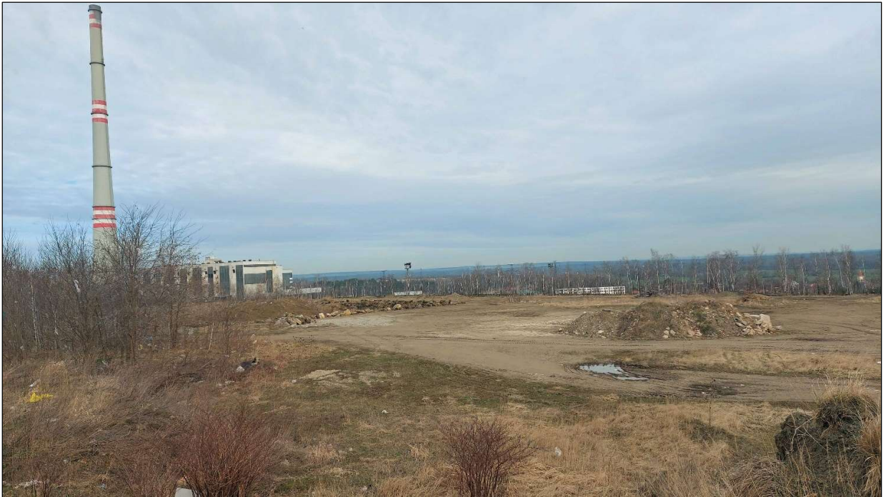
Foto 4: V těchto místech budou ukládány odpady v rozšíření Sever (Geo Vision s.r.o., březen 2021)
