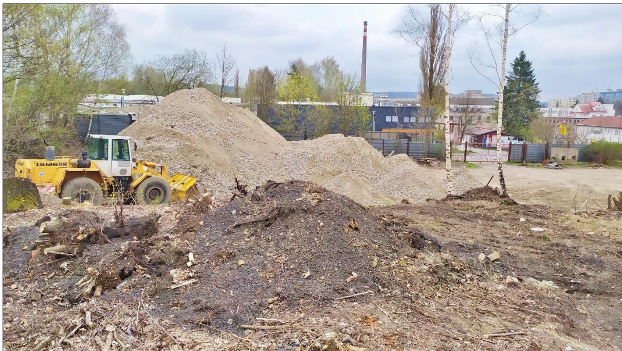
Fotografie lokality ze severu areálu bývalé plynárny do Poličské ulice směrem k JV (Jiří Marek 02.05.2023)
