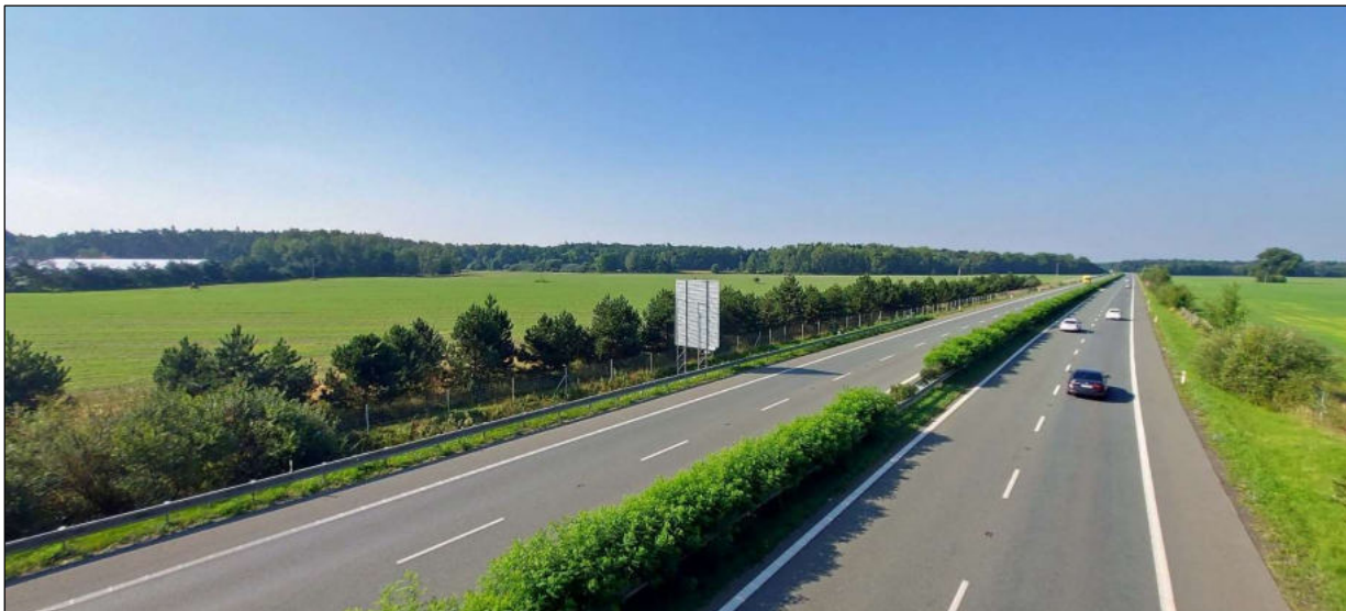
Foto 3: Pohled na místo budoucího ochranného valu II od severu z mostu nad komunikací I/37 ve směru Hrobice – Hrobický Dvůr. Přírodní rezervace Baroch je až u lesa na obzoru vlevo.
