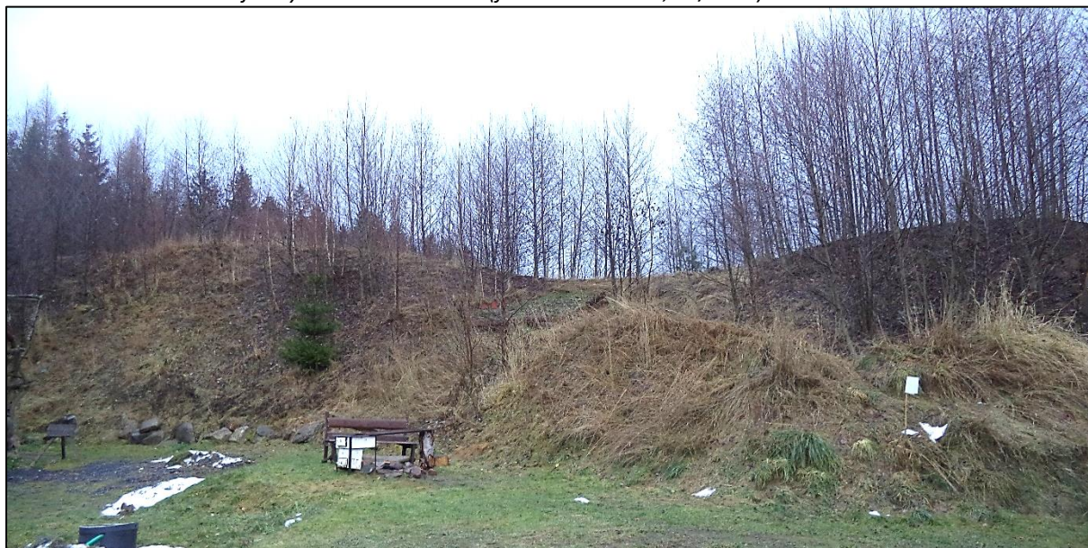
Obrázek 35: Zemní val v jihovýchodní části areálu (foto: A. Machová, 12/2023)
