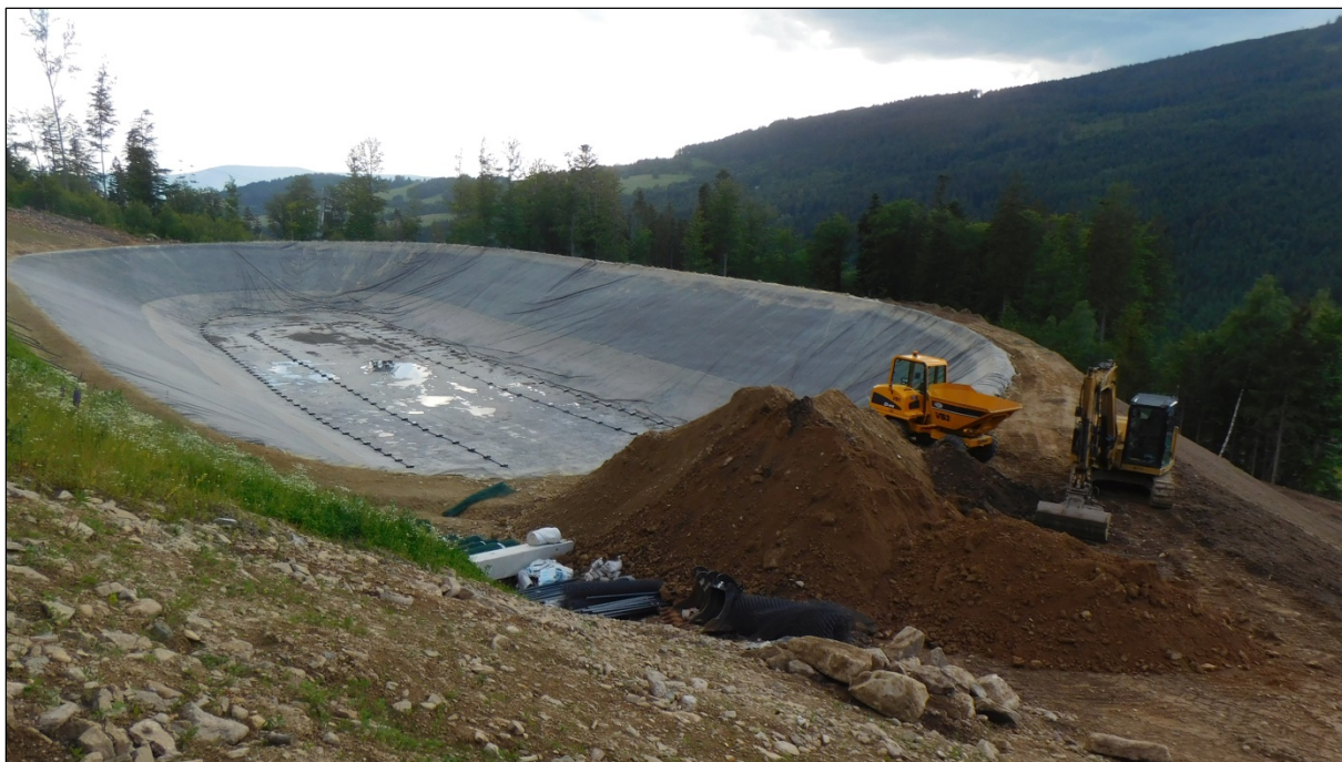
Obr. 22 a 23: Nahoře: vodní nádrž 1 – úprava hráze a oprava těsnění. Dole: Výstavba vodní nádrže 2 (červen, 2022).
