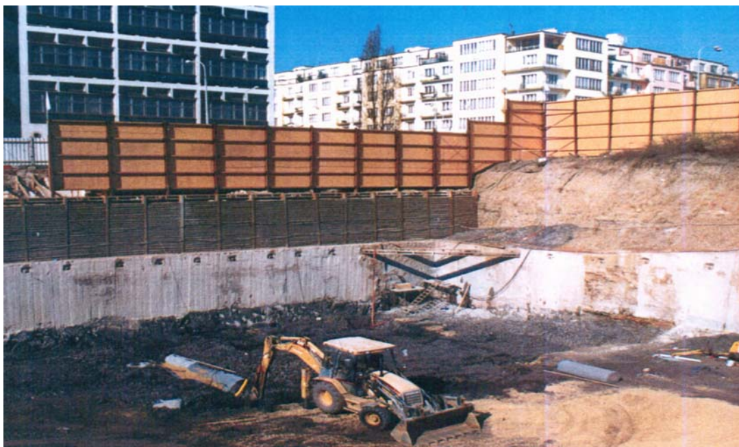
obrázek 16 – příklad s stavenišťe protihlukovými stěnami v obytné zástavbě
