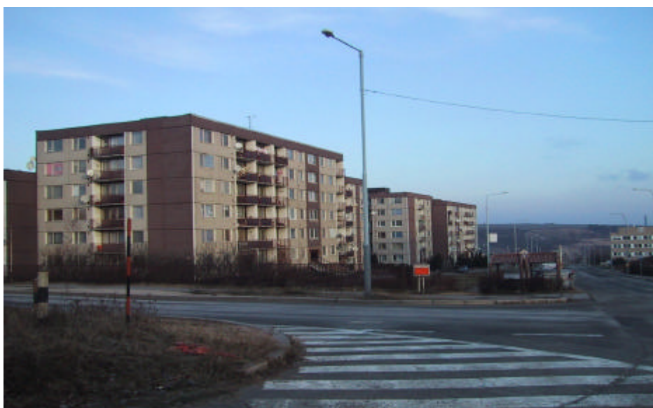
obr.8 Pohled do ulice Geologické z ul. Slavínského
