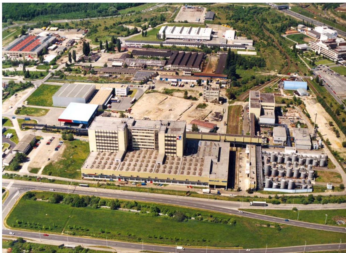
Obrázek 1 – Letecký snímek areálu BaL – pohled od východu
