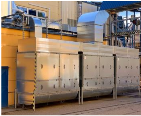
Obrázek 24: Vzorová stříkací stěna a filtry na VOC
