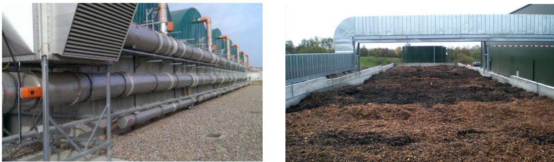
Obrázek 27: Vzorový odvod vzduchu a biofiltr
