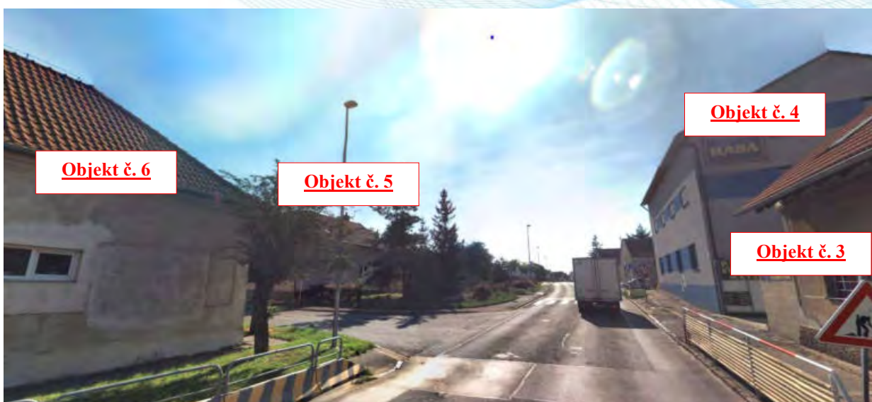
Obrázek 21: Akusticky chráněné objekty č.3, č. 4, č. 5 a č. 6
