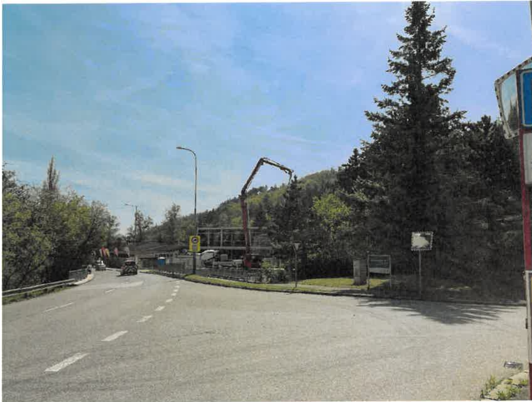
Pohled od napojení cementárny na ulici K Cementárně
