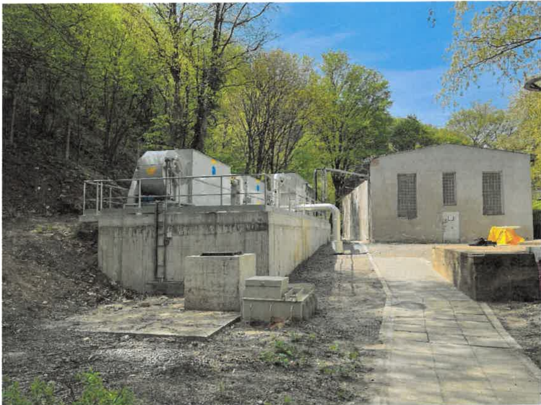
Pohled na věže směrem Z (k objektu vodárny)
