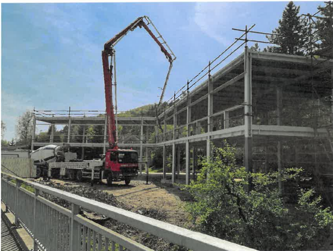
Detailní pohled na novostavbu (směrem k RD)
