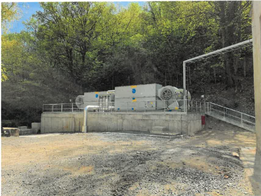
Pohled od objektu vodárny
