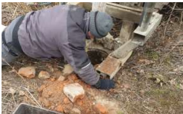
Obrázek: velké kusy cihel komplikující průběh vrtání sondy J1 v půdorysu bývalého objektu
