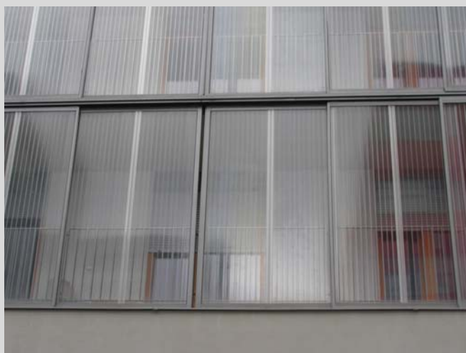
Obr. 2 Pohled na objekt Želetavská č.p. 5 (čelní fasáda – detail)
