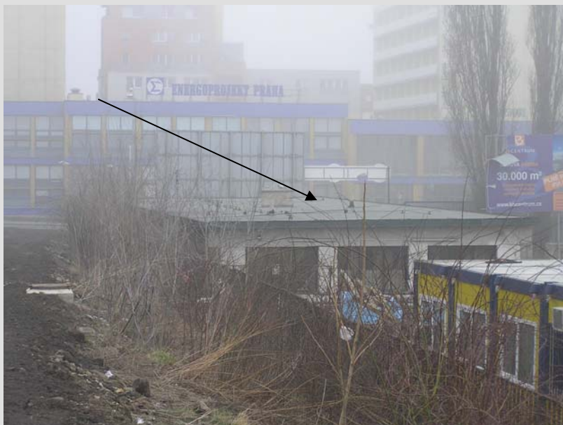
Obr. č. 1 Stávající objekt určený k demolicí
