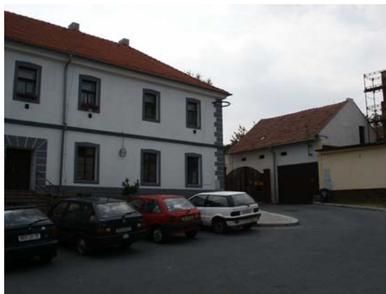
opravený areál č.p. 34
