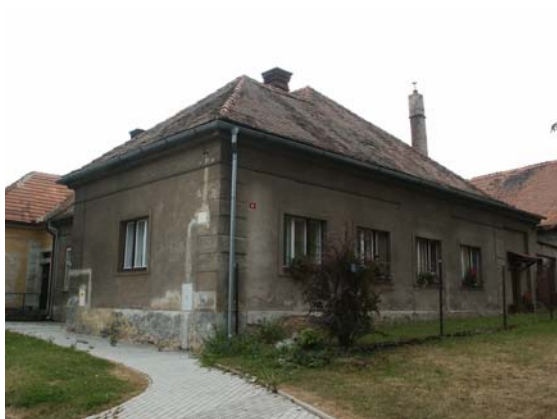
dům č.p. 21, v pozadí střecha statku (H)
