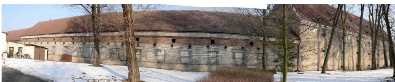
Panoramatický pohled za objekty statku sousedící s Vinořským parkem - chráněné území dočasně dotčené stavbou
