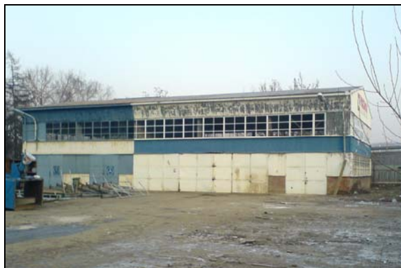
Západní pohled na objekt třídírny
