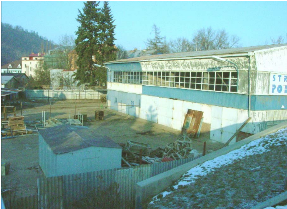
Obr. 2. Pohled na výrobní halu
