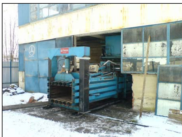
Návoz a instalace technologie
