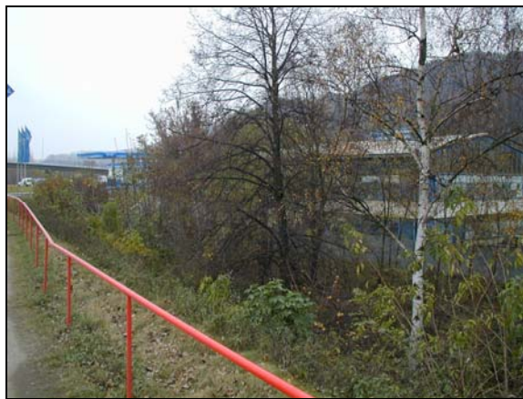
Severovýchodní pohled na zařízení
