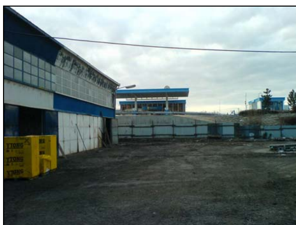
Nádvoří s třídírnou – severní pohled
