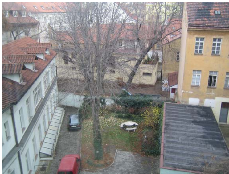
Obrázek 15 – Pohled na dvůr z horního okna uličního objektu
