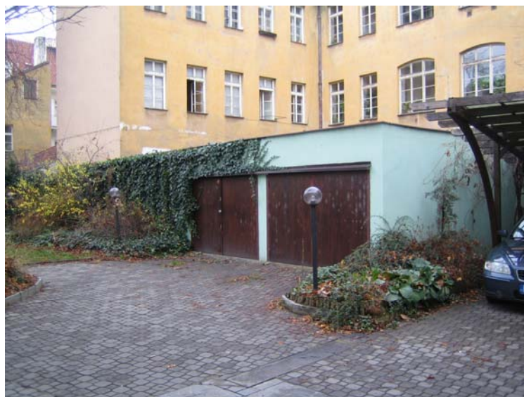
Obrázek 17 – Pohled na garáž ve dvoře určenou k demolicí
