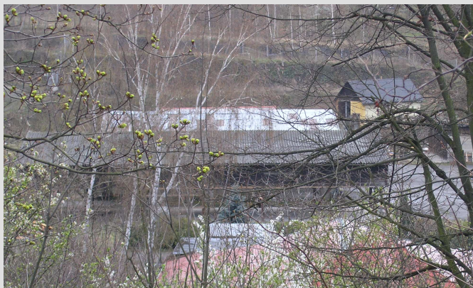
Obr. č. 1 Stávající objekty určené k demolic
