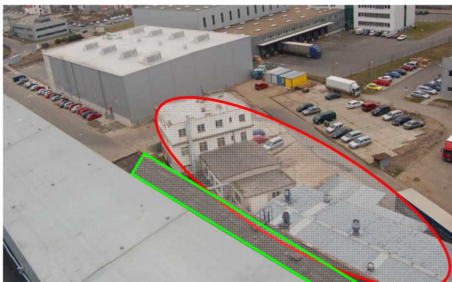
Obrázek 10 – Fotografie posledních objektů původního areálu určených k demolici
