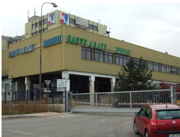
Obr.14 Severní vjezd z ul. K Hrušovu
