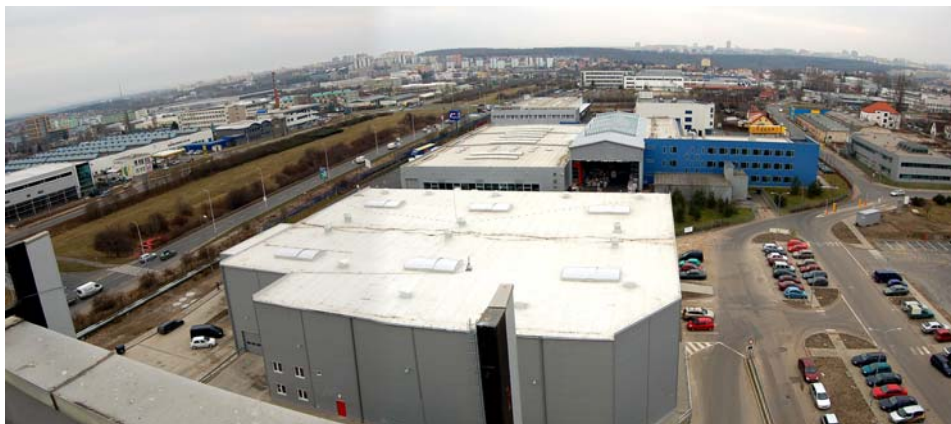
Obrázek 16 – Pohled ze střechy monobloku jižním směrem
