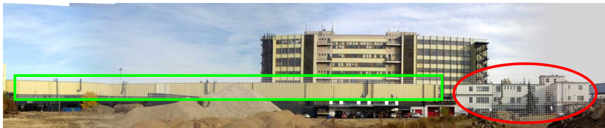
Obrázek 11 – Fotografie posledních objektů určených k demolici (vzadu vysoký objekt monobloku)
