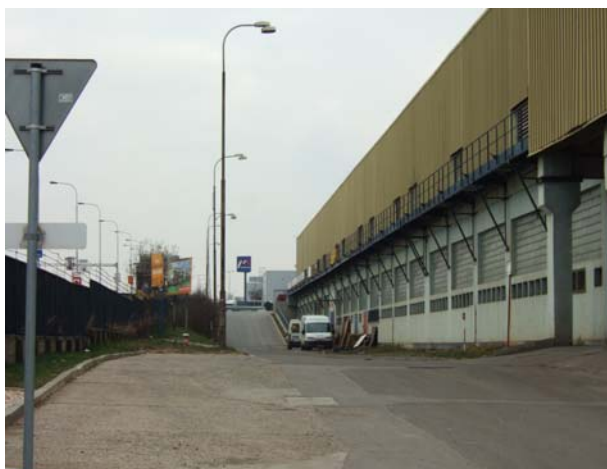
Obr.7 Východní fasáda monobloku
