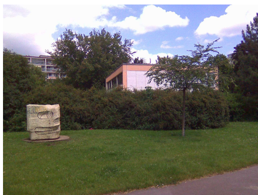
OBR 1 Mateřská škola Šluknovská
