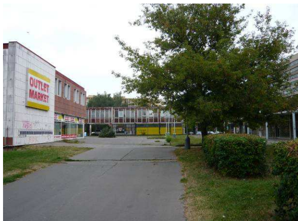
Severovýchodní pohled na oblast záměru z ulice Jablonecká
