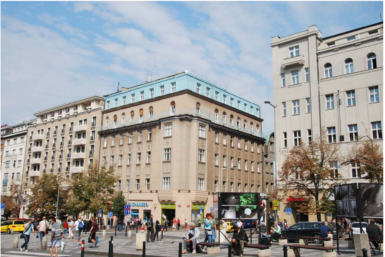
Pohled na budovu Václavského náměstí 74 z prostoru náměstí.
