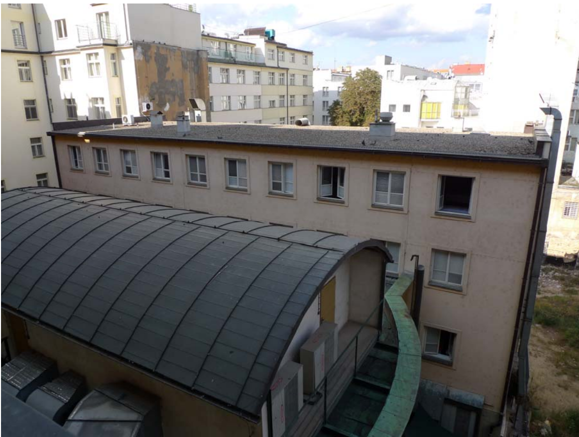
Pohled na dvorní trakt hotelu Jalta z hlavní budovy hotelu.
