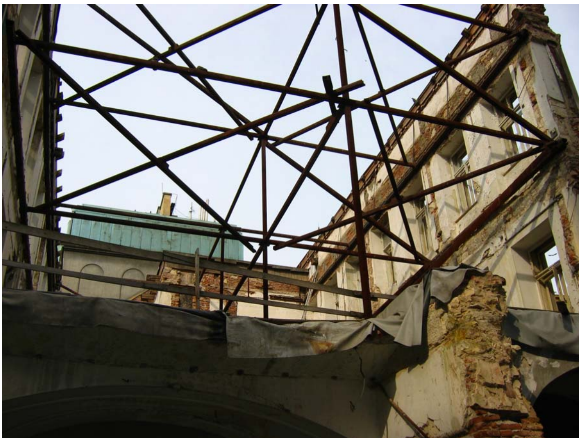
Dočasná opěrná konstrukce fasády objektu Opletalova 3.
