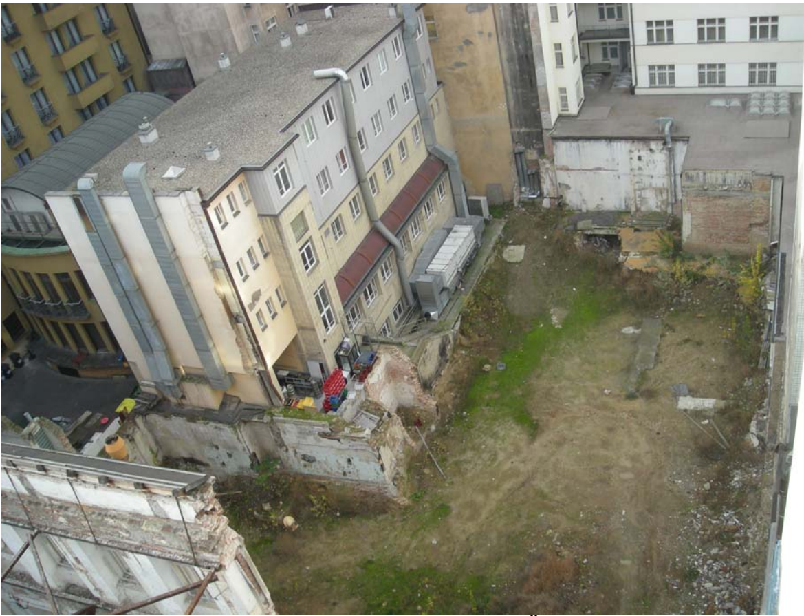
Pohled na dvorní trakt hotelu Jalta ze střechy budovy ČTK.
