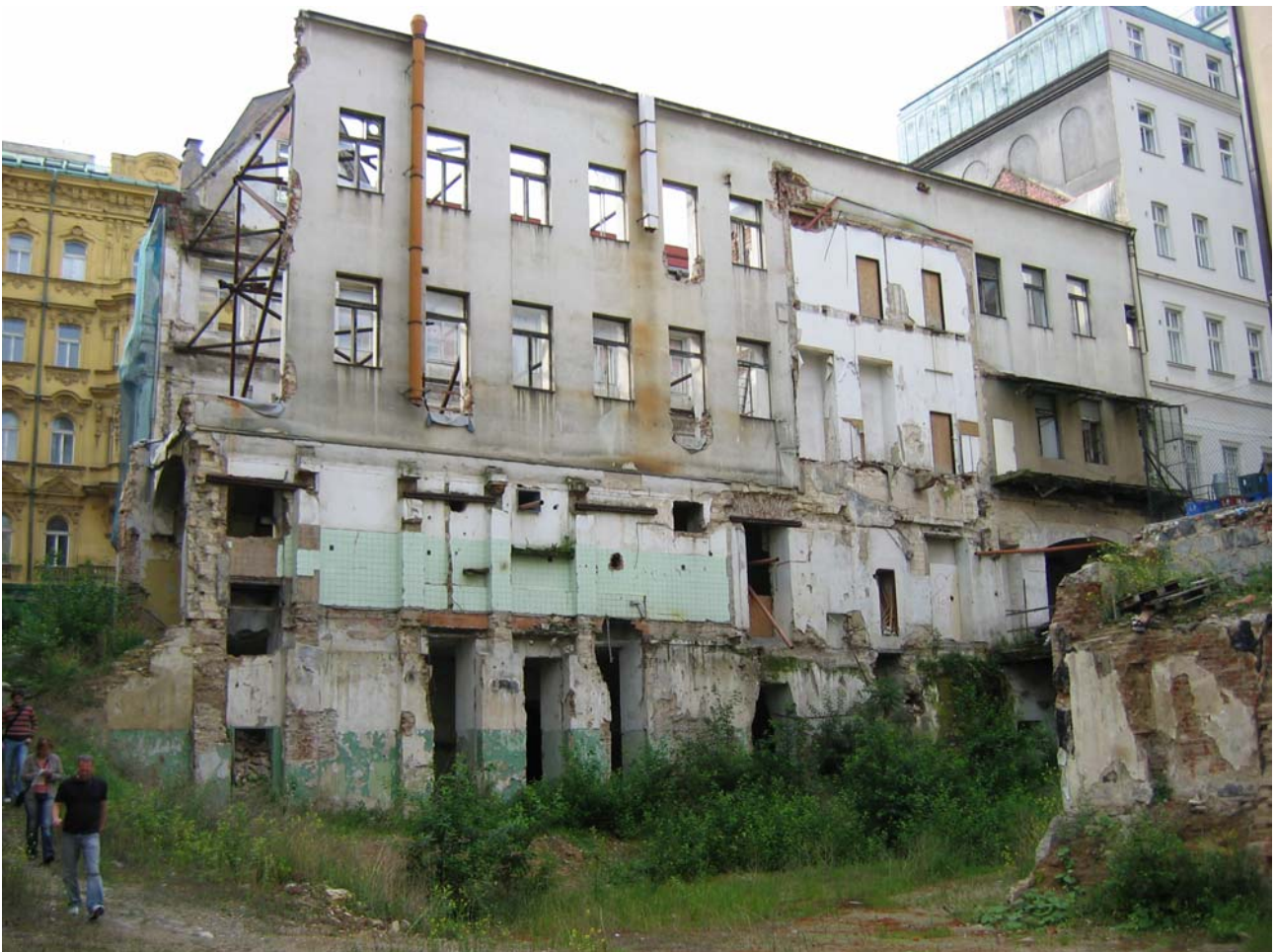
Pohledy na torzo budovy Opletalova 3 ze stávajícího prostoru vnitrobloku.
