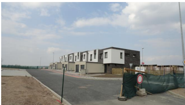
Referenční bod č. 4 rodinné domy ve výstavbě
