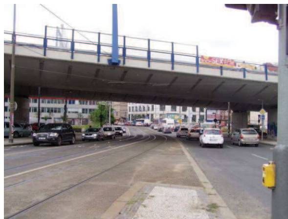
Foto č. 4: Pohled na Plzeňskou ulici směrem k ulici Radlická
