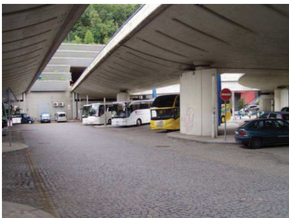
Foto č. 3: Pohled na předpokládaný výjezd z podzemní garáže záměru
