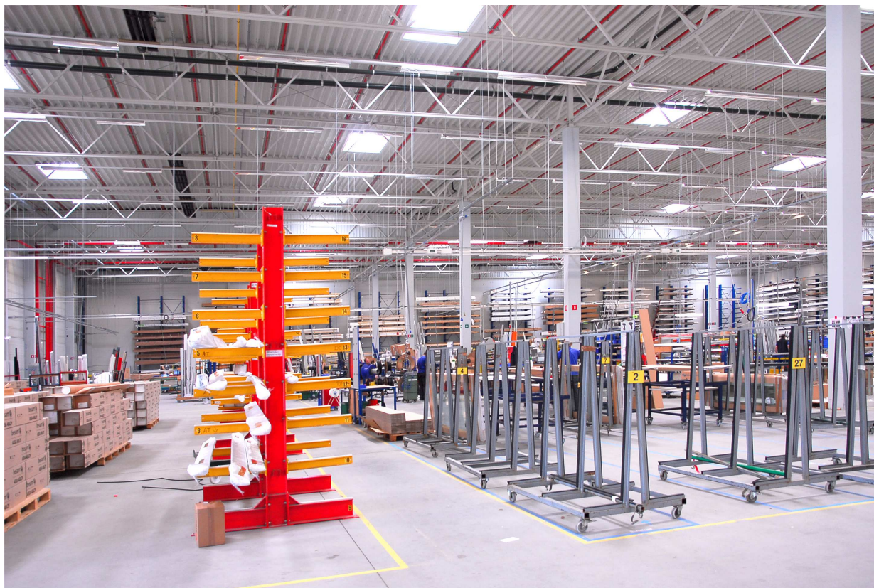
Stávající vnitřní prostory haly
