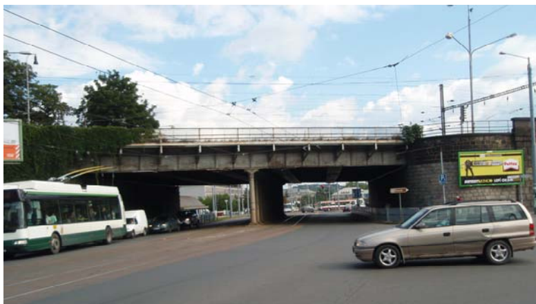
Obr. pohled na most severní viadukt
