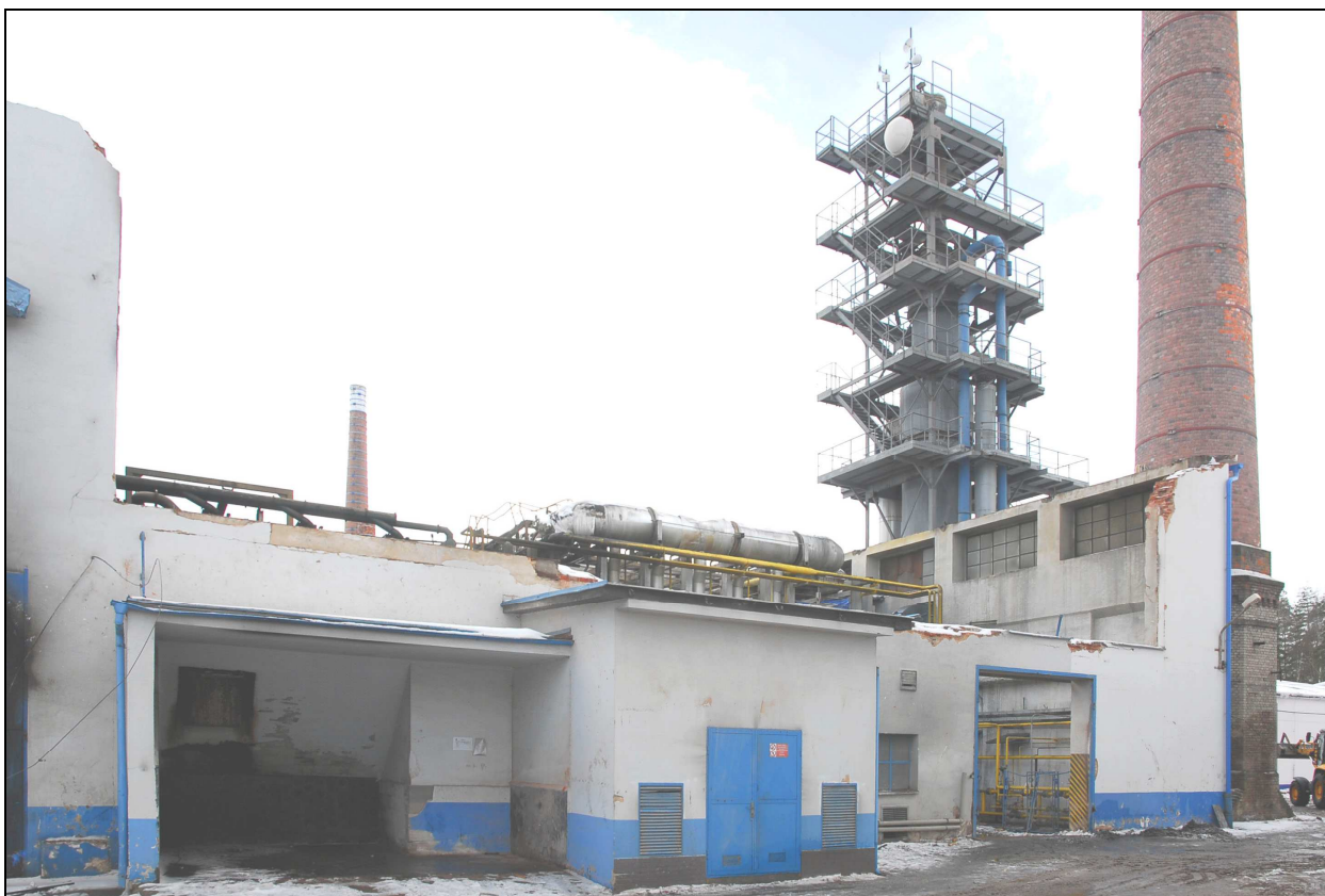
Místo rekonstrukce hutní haly, stará hala, stav 10.2.2010
