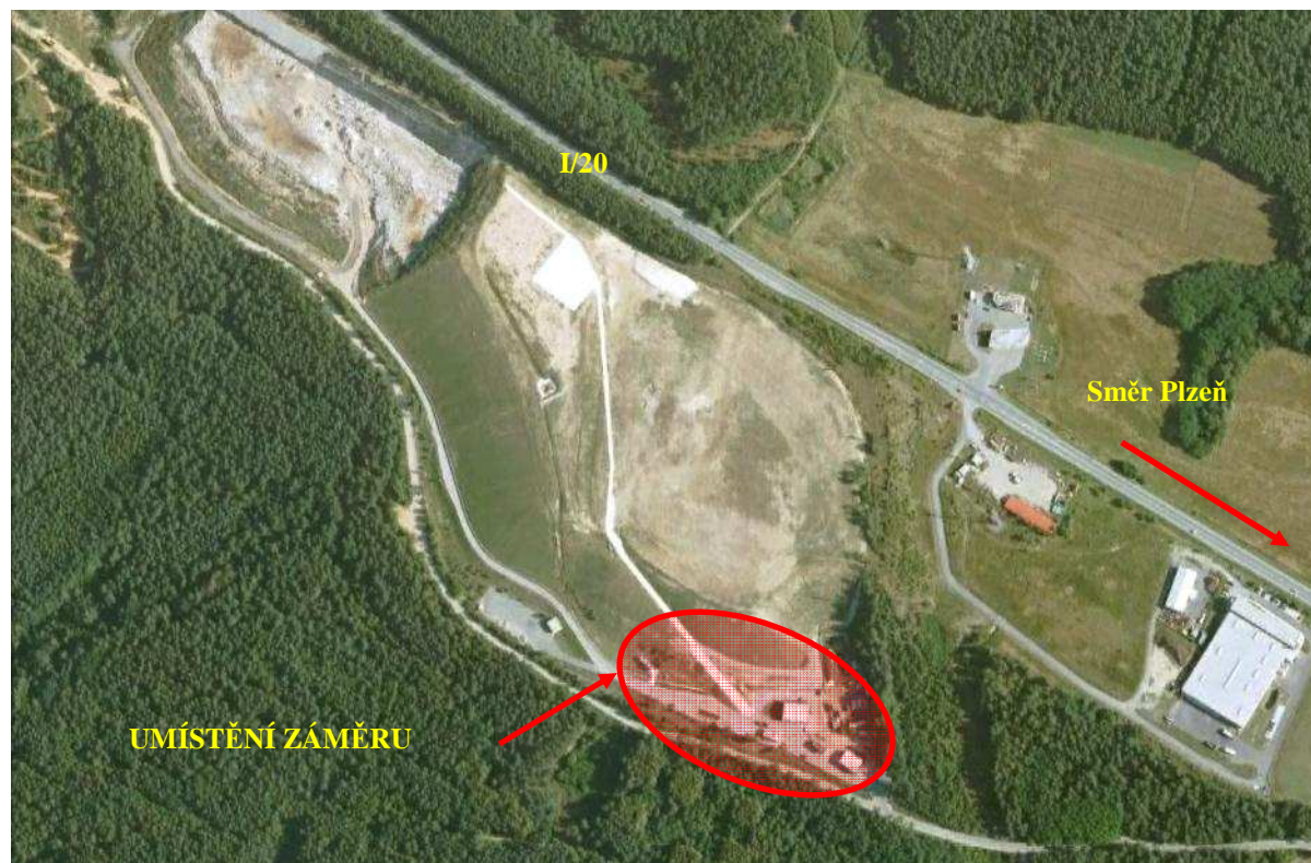
Obr. č. 1 Letecký snímek s umístěním záměru
