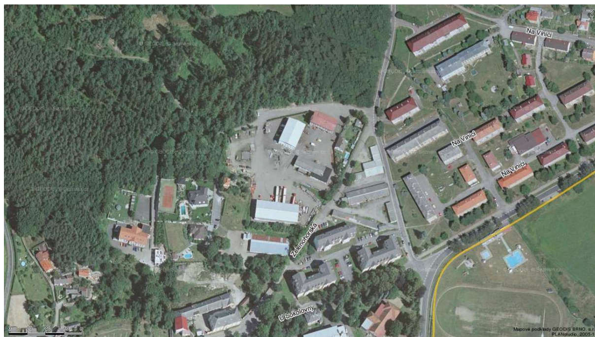
Obr. 6.1 - letecká fotografie - stávající stav
