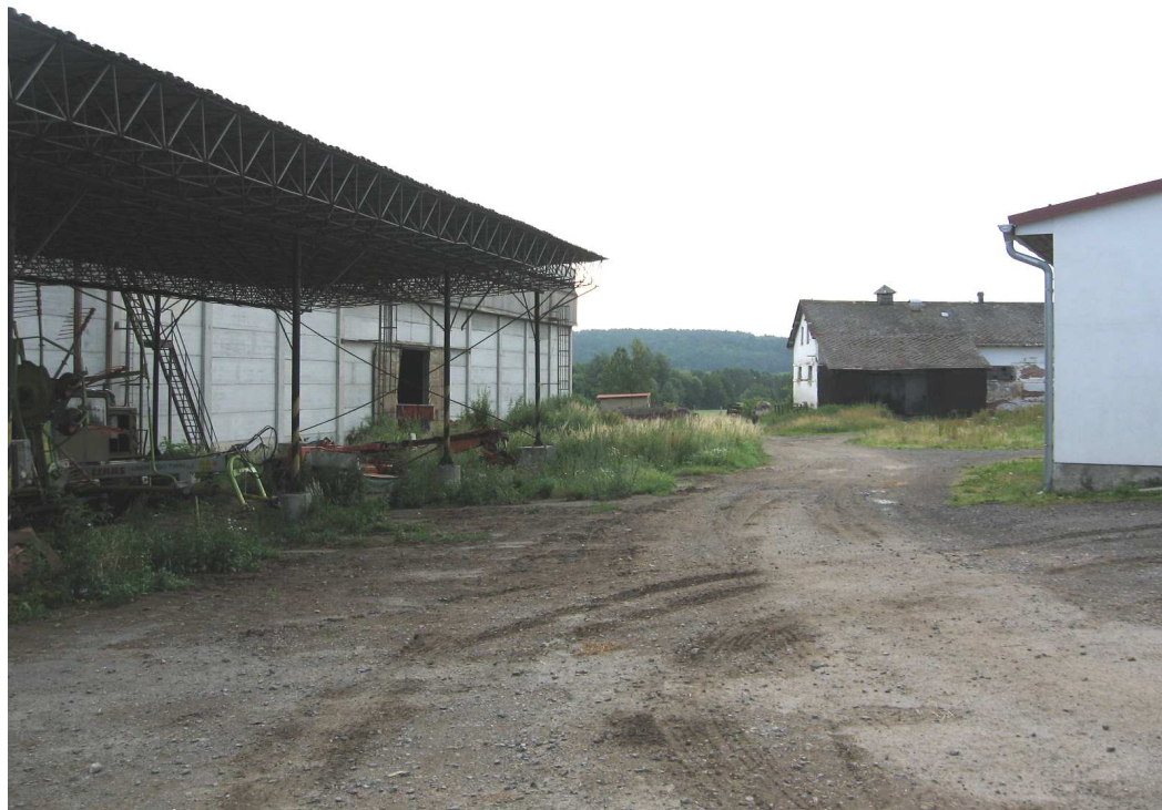
Pohled na místo výstavby od SZ
