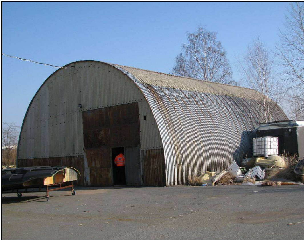
Foto č. 3: Obloukový sklad určený po úpravě pro skladování nebezpečných odpadů
