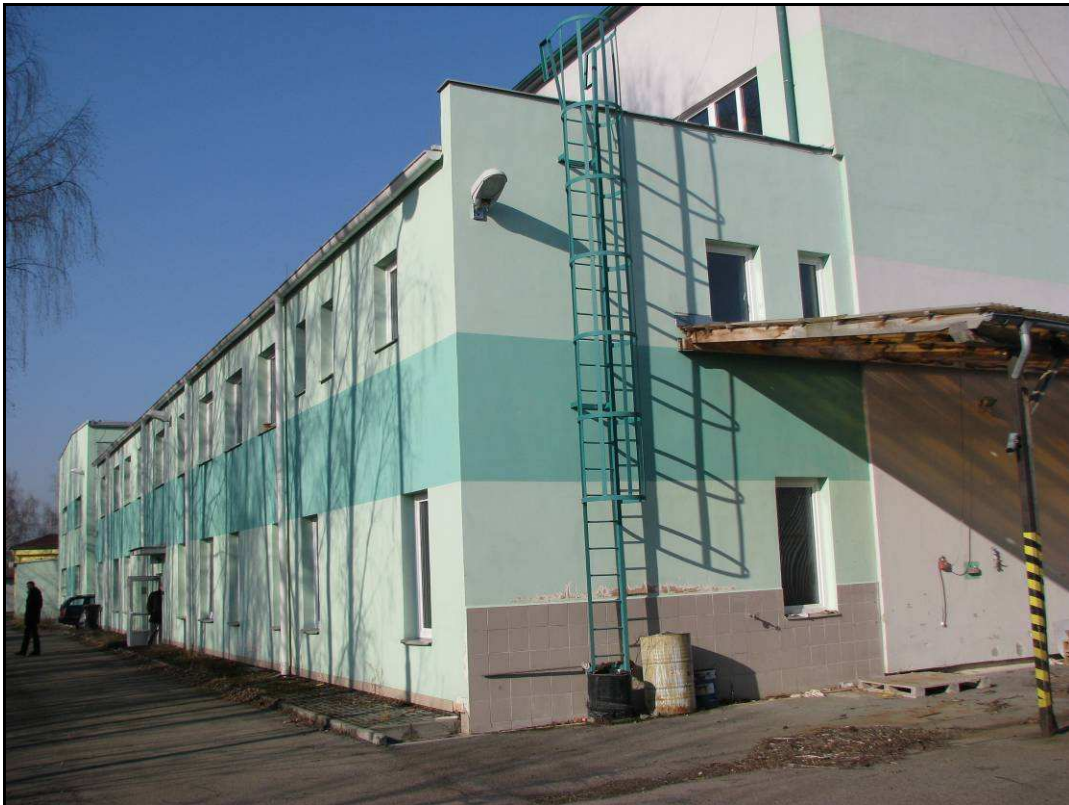
Foto č. 1: Administrativní budova napojená na halu určenou pro úpravu odpadů v další etapě výstavby areálu
