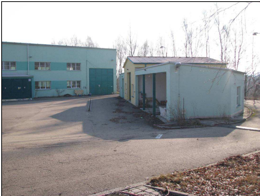
Foto č. 4: Budoucí sklad prázdných obalů a plocha pro parkování nákladních vozidel
