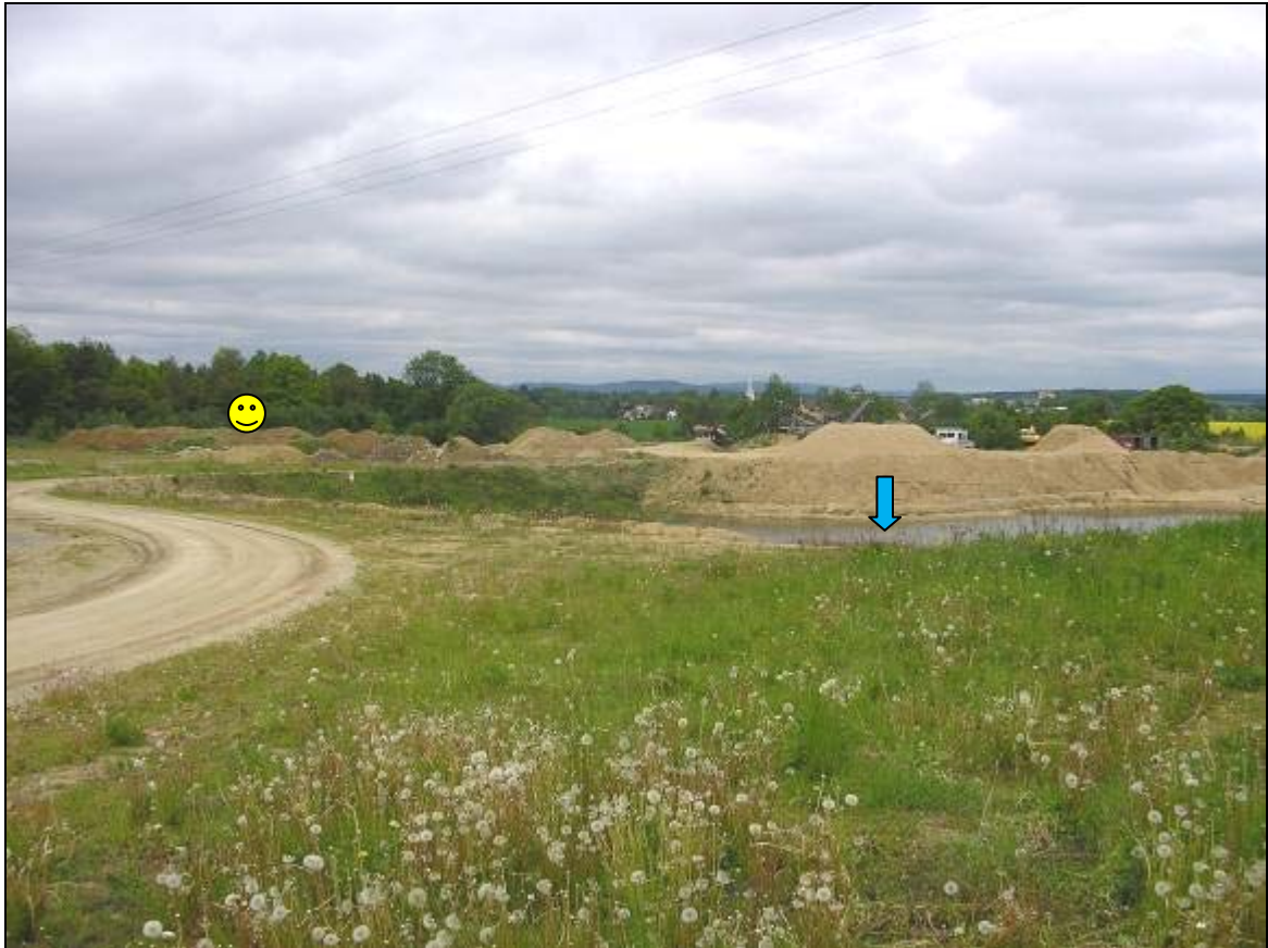
Obr. č. 13. Pohled do pískovny od jihu od příjezdové cesty; na foto a v důlní mapě dole je vyznačena modrou šipkou občasná vodní plocha, za ní jsou patrné deponie upravené suroviny; rekultivovaná vodní plocha – vyznačena „smajlíkem“, z níž je prováděn odběr vody pro úpravu, nacházející se v západní části pískovny je na foto patrná díky vegetaci (provedené rekultivaci s přirozenou sukcesí pionýrských dřevin)
